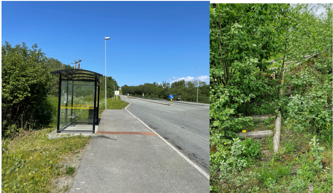
Figur 5: Bussholdeplass i vestligretning i Hølandvegen, og gjengrodd trapp som går til bussholdeplassen. (Bilde: NIRAS)
